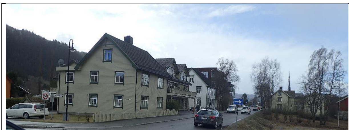
Orkdalsveien 72 til venstre i bildet og Orkdalsveiens nyeste bygning lengst mot sør.
