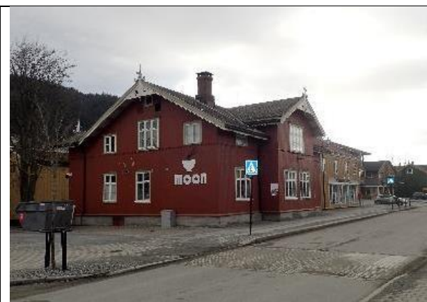
Orkdalsveien 50, oppført i 1880.
