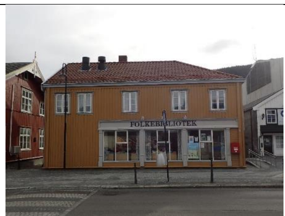
Bibliotekbygningen, oppført i 1880.
