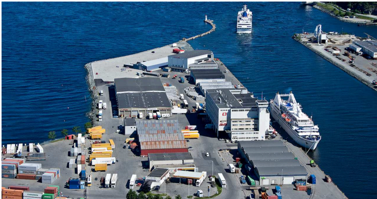
Pir II på Brattøra i Trondheim havn.
